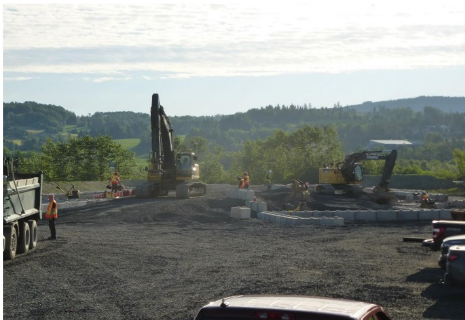
Le chantier dans le cadre du projet de relocalisation de l'écocentre d'Amqui a été lancé en juin dernier.
